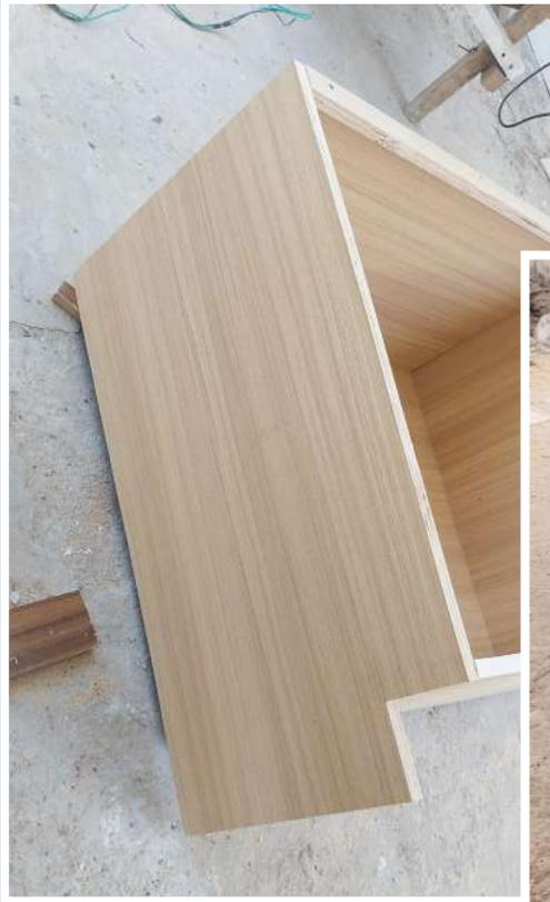
Meuble de salle de bain ajusté de 5cm en hauteur, et côté remplacé.
